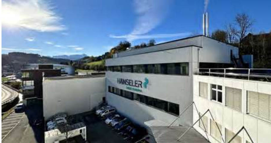
Vue extérieure de la nouvelle construction BPF à Herisau.
