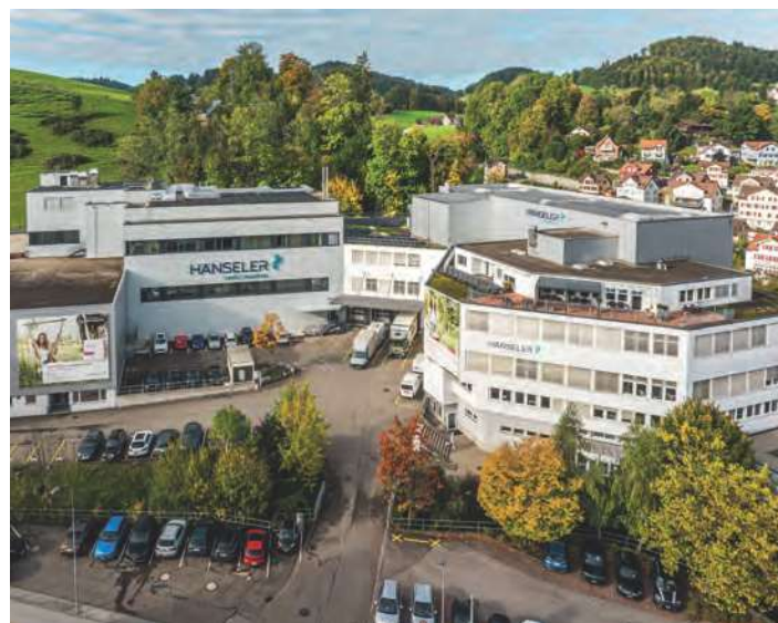
Das neue Produktionsgebäude ist ein Bekenntnis zum Standort Herisau. Häseler sichert damit im Appenzellerland pharmazeutisches Know-how und Arbeitsplätze.
