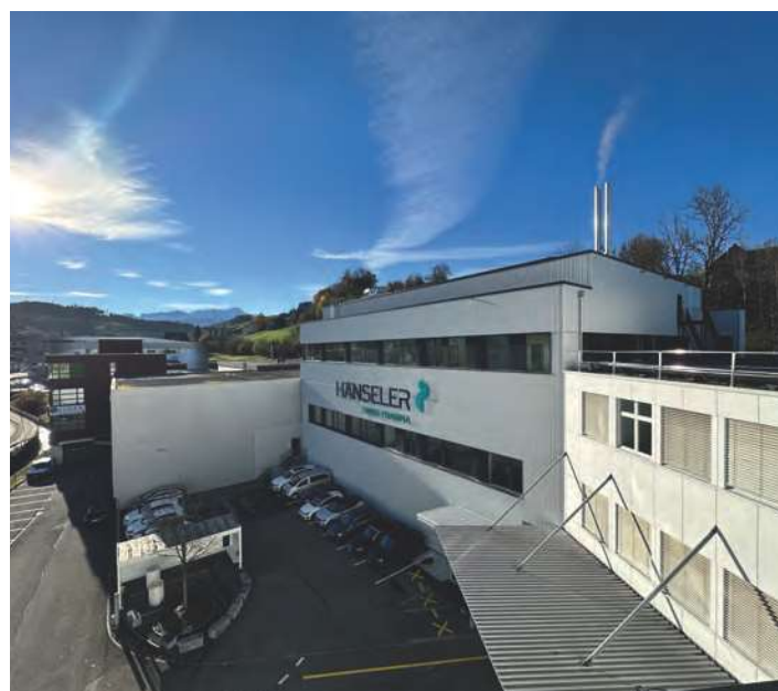
Der Neubau der Häseler AG ist ein GMP-Produktionsgebäude – also ein Gebäude für die Herstellung nach strengen pharmazeutischen Qualitätsstandards.
